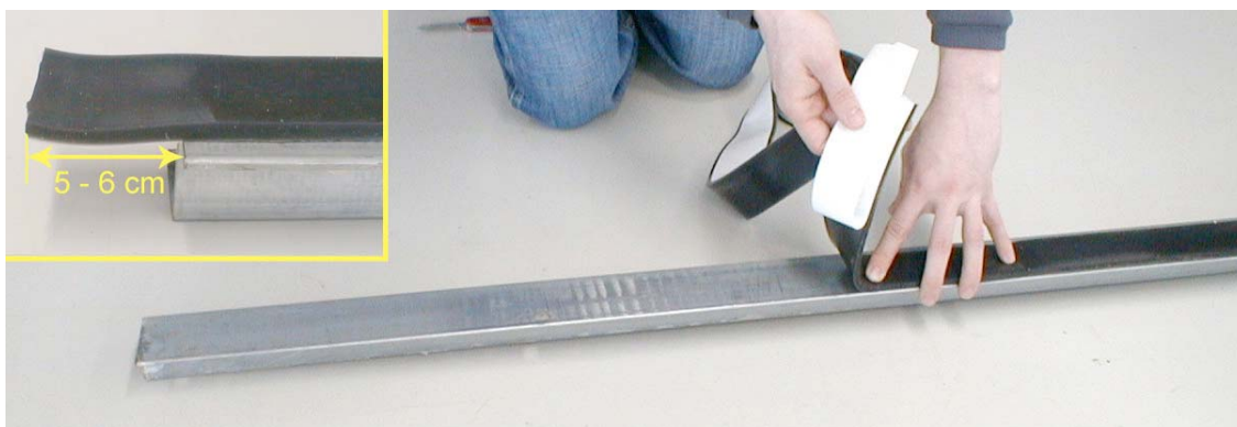
Abbildung 2.2: Aufkleben der Zahnschienendichtung (WP W04-17 Z)
