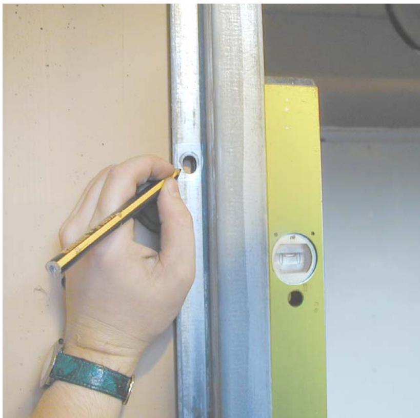
Abbildung 2.1: Verwendung der Zahnschiene als Bohrschablone (Wasserwaage sorgt für ausreichend parallele Montage der Zahnschienen)
