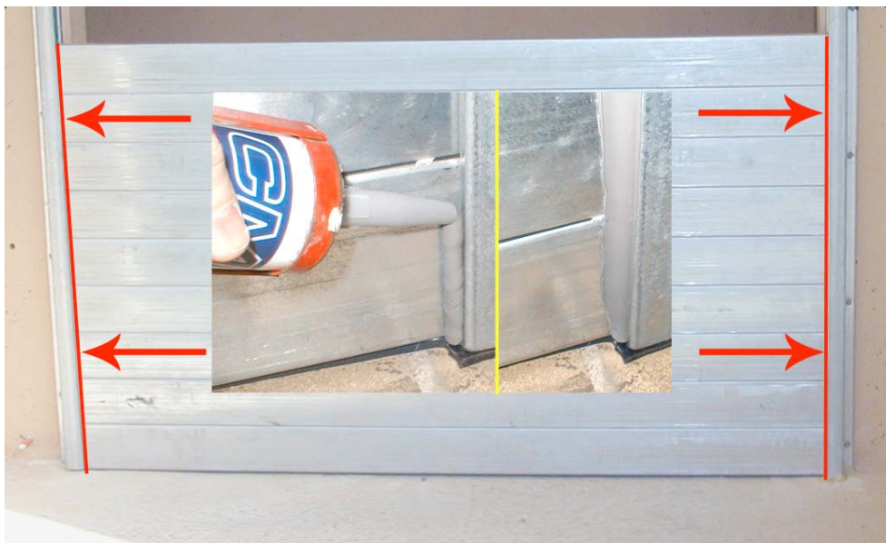
Abbildung 2.8: Abdichten der senkrechten Fugen (rote Linien, Pfeilmarkierung) mit Silikon
