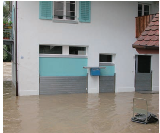
August 2007 – Im Schweizer Kanton Aargau tritt die Reuss über die Ufer. WP WASTO verhindert den Wassereintritt in das Gebäude. Die Räume hinter dem Stahlsystem bleiben trocken und sauber.
